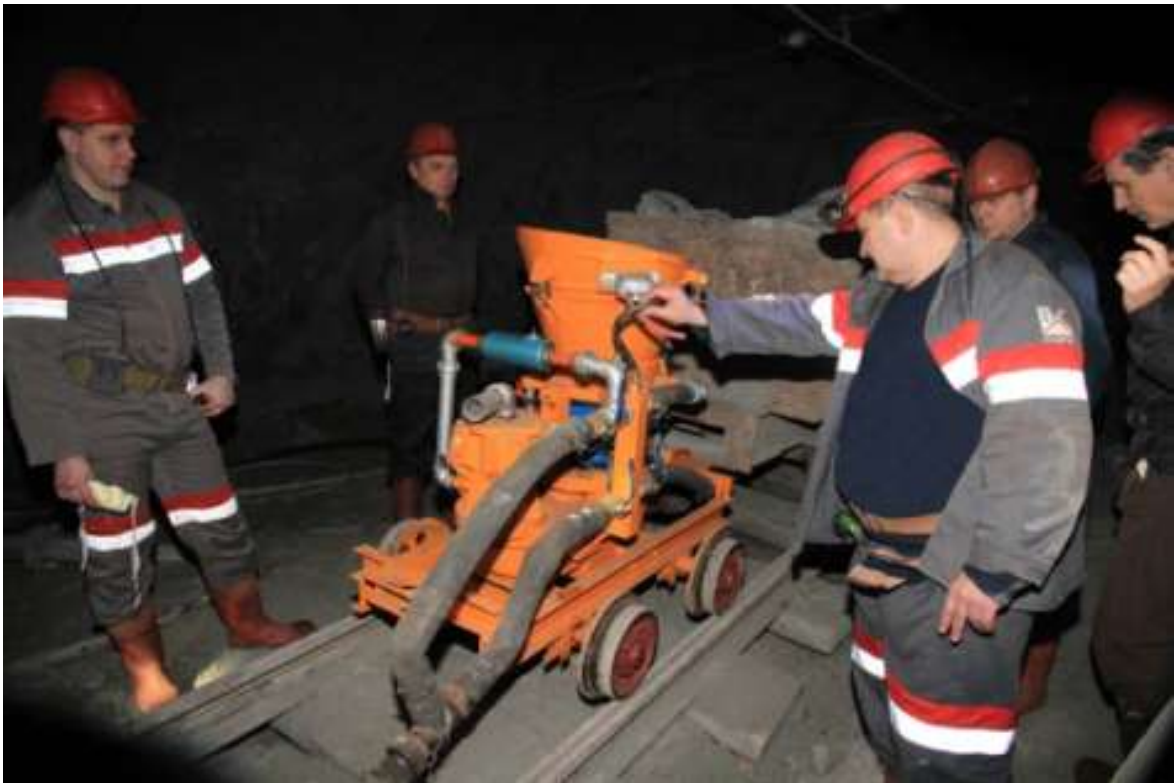
Установка для кріплення виробок спеціальною торкет- сумішшю «Meuco Piccola» фірми BASF
