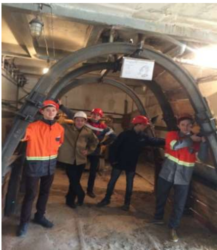
Спорудження металевого арочного гірничого кріплення
